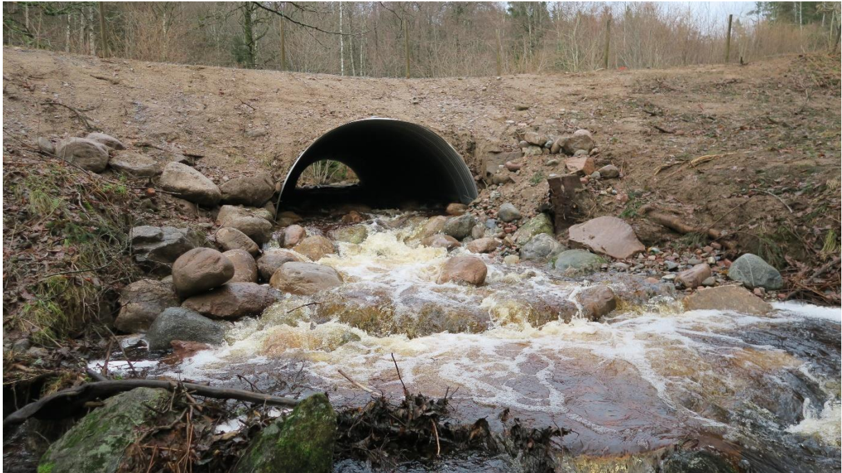
Bild 1. Den nedre av vägtrummorna, trumman vid Dalen, efter åtgärdande 2016.
