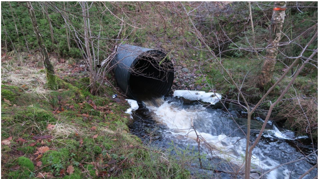
Bild 5. Dammhagen 2, före åtgärd.
