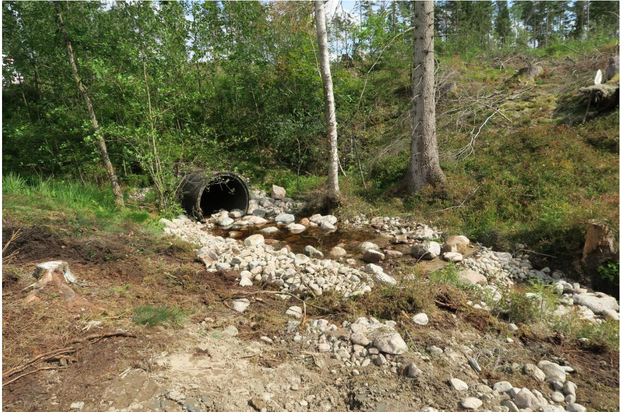
Bild 6. Dammhagen 2, efter åtgärd. Lågflöde.
