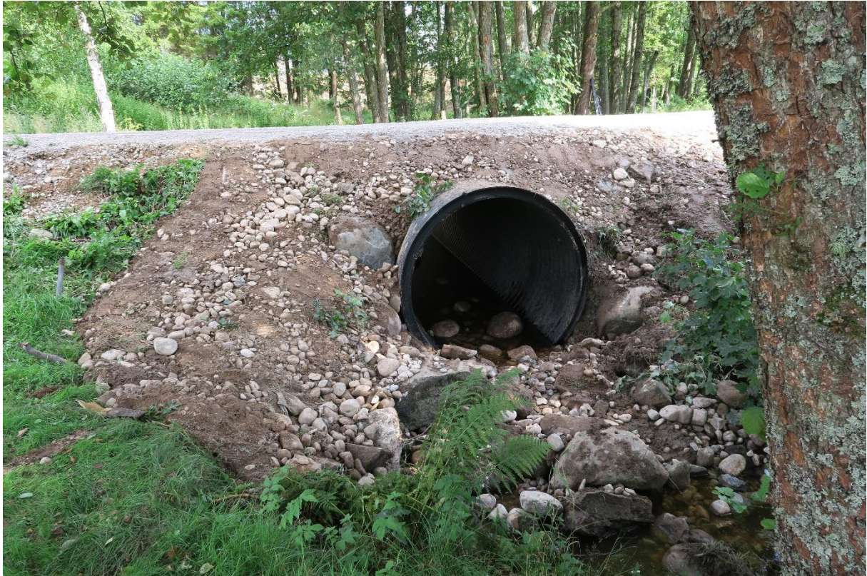
Bild 3. Dammhagen 1, efter åtgärd. Lågflöde.
