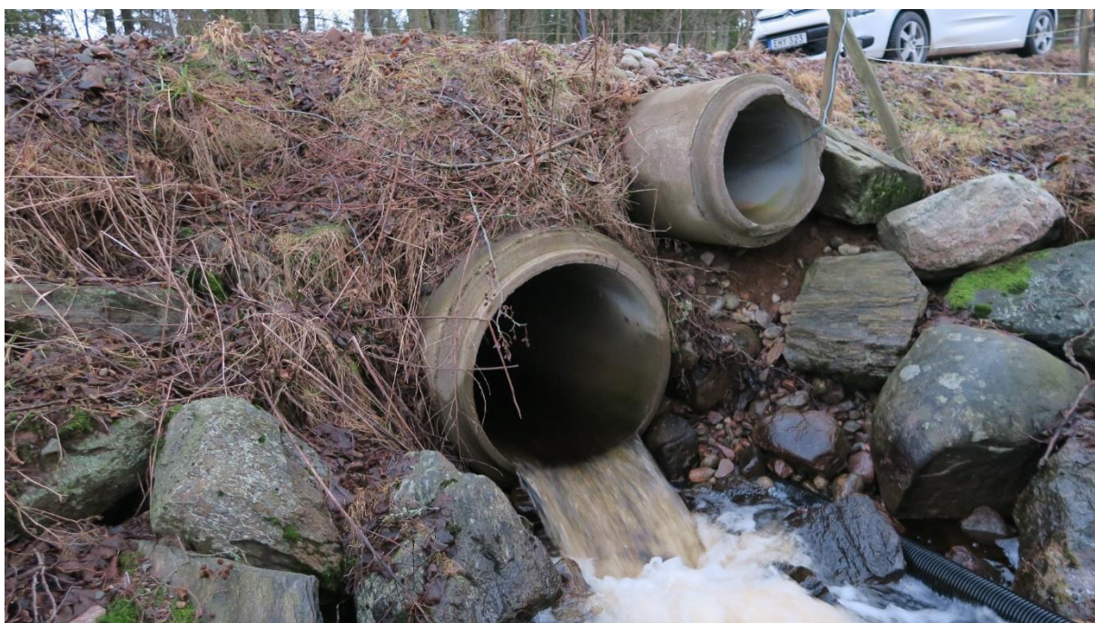
Bild 2. Dammhagen 1, före åtgärd.
