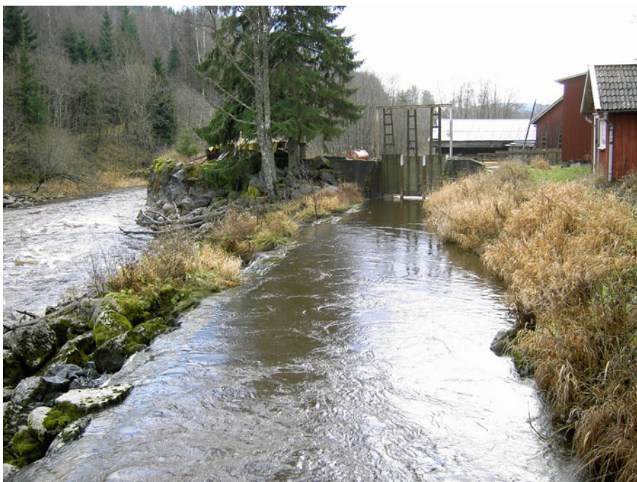
Foto 3. Intagskanalen nedströms dammen
