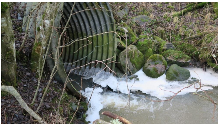
Bild 3. Krokstadsbäcken, hinder D2, vägtrumma.
