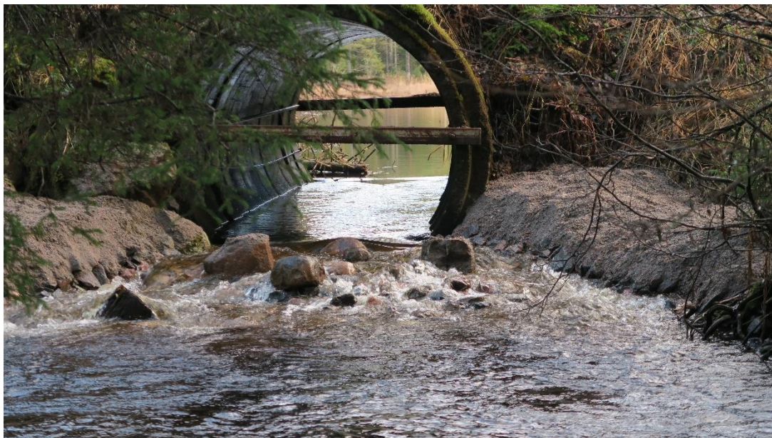
Bild 20. Vägtrumma vid Pipenvägen. Trumman åtgärdades som vandringshinder 2016.
