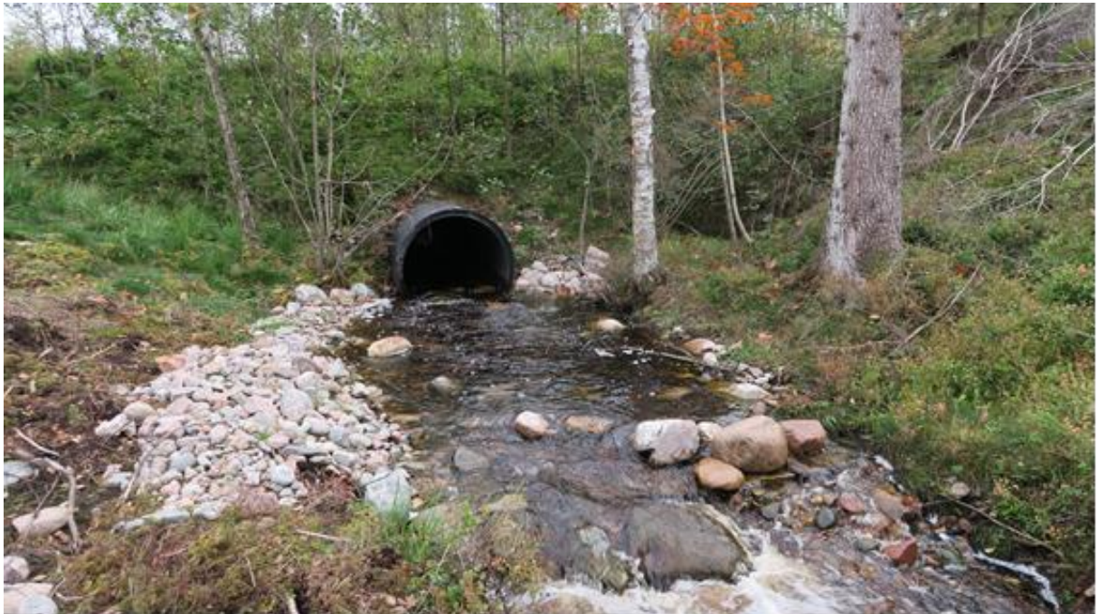
Bild 2. Vägtrumman nedströms lokal O Dammhagen i Åsanebäcken efter åtgärd år 2017. Botten nedströms trumman höjdes upp med natursten och fallet vid trummans utlopp undanröjdes.
