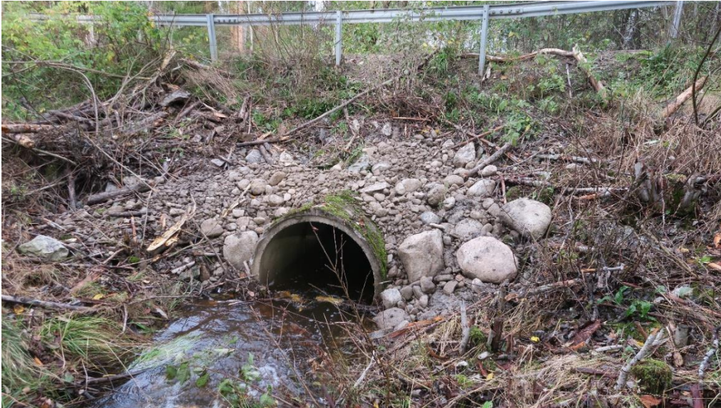
Bild 8. Vägtrumman vid Klockaredalen efter åtgärd. Inloppet.
