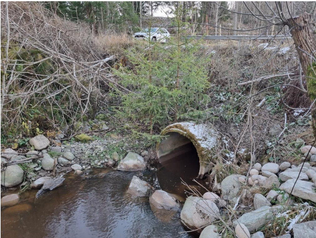
Bild 9. Vägtrumman vid Klockaredalen efter åtgärd. Utloppet.
