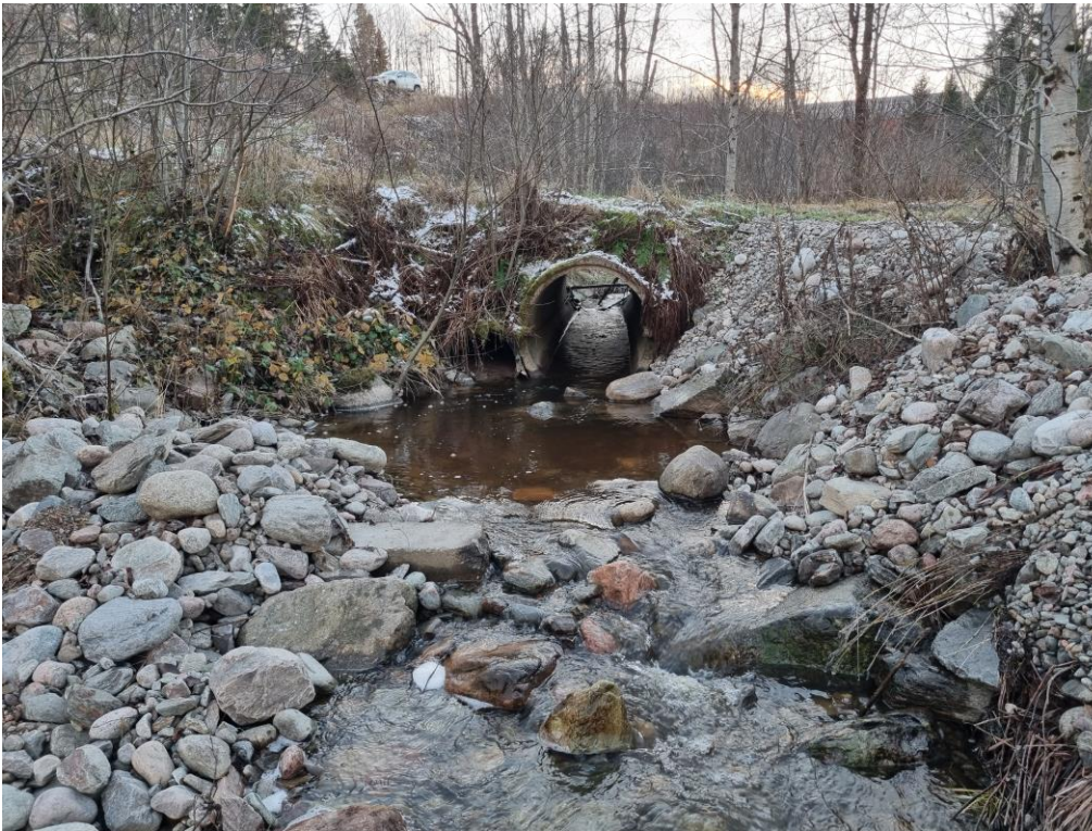
Bild 7. Vägtrumman vid Prästbol efter åtgärder. Utloppet.
