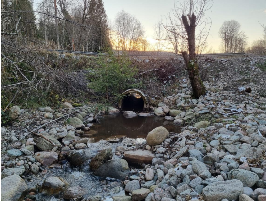
Bild 10. Vägtrumman vid Klockaredalen efter åtgärd. Utloppet.
