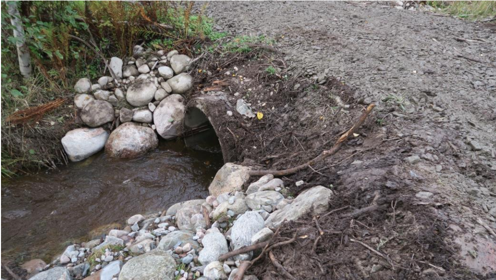
Bild 7. Vägtrumman vid Prästbol efter åtgärder. Inloppet.
