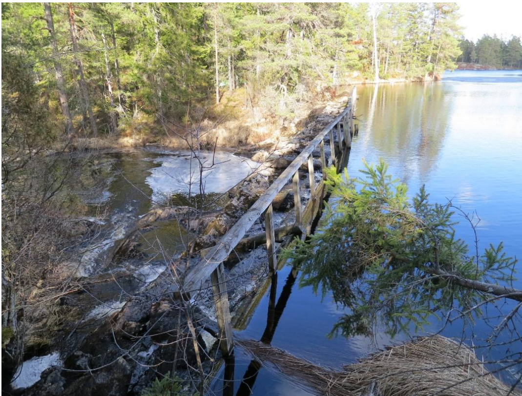
Bild 18. Regleringsdammen i Nedre Idetjärnen (hinder D5). Bilden tagen 2013.
