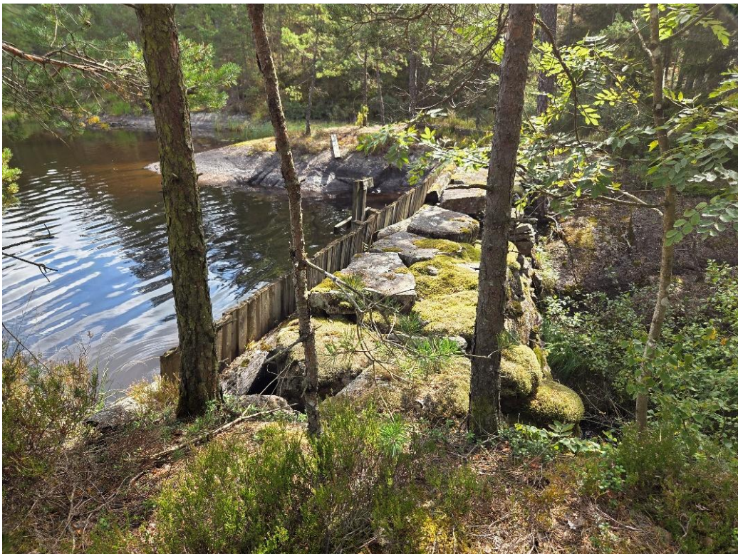
Bild 20. Regleringsdamm i utloppet av Nedre Idetjärnen (hinder D7). Bilden tagen 2025.
