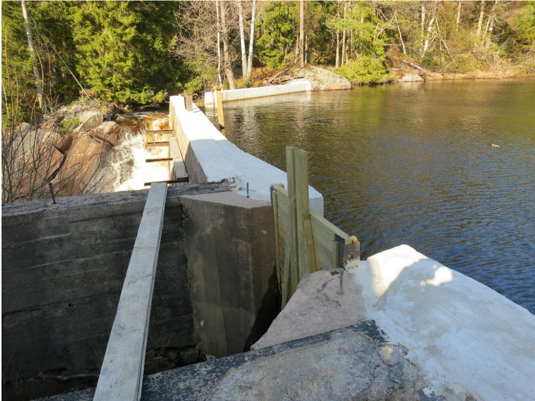
Bild 17. Kraftverksdammen i Nedre Idetjärnen (hinder D4). Bilden tagen 2013.
